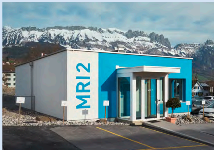
Der Modulbau für die MRI-Untersuchungen am Spital Grabs.
