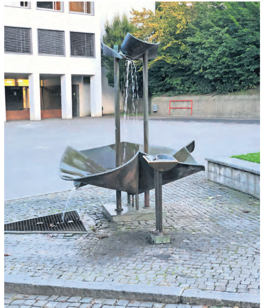
Auch die öffentlichen Anlagen – hier der Brunnen vor dem Dorfschulhausplatz – werden regelmässig kontrolliert.
